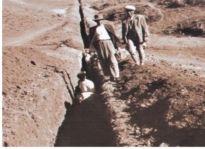
Foto 3: Karaçalı İçme Suyunun Elazığ'a getirilme Çalışmaları (1948)
